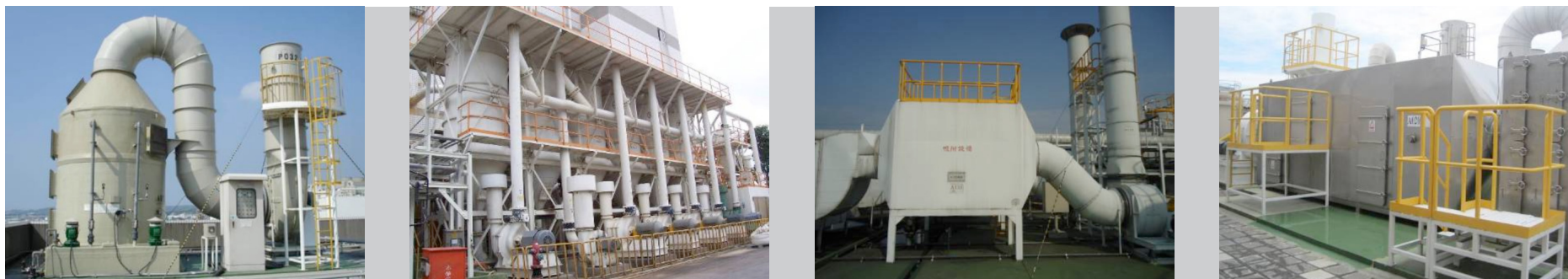
圖 3.14 空污防制設備照片（填充式洗滌塔、袋式集塵器、活性碳吸附塔、UV-C 反應塔）
