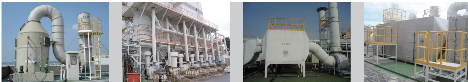
圖 3.14 空污防制設備照片（填充式洗滌塔、袋式集塵器、活性炭吸附塔、UV-C 反應塔）
