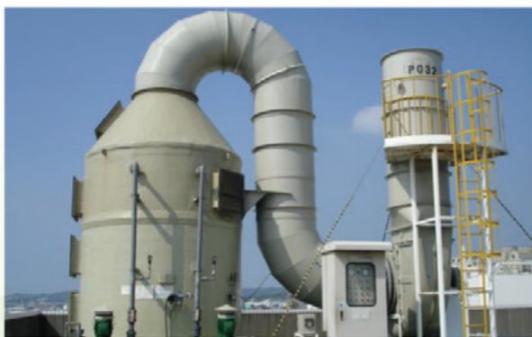
(填充式洗滌塔、袋式集塵器、UV-C反應塔、活性炭吸附塔)
